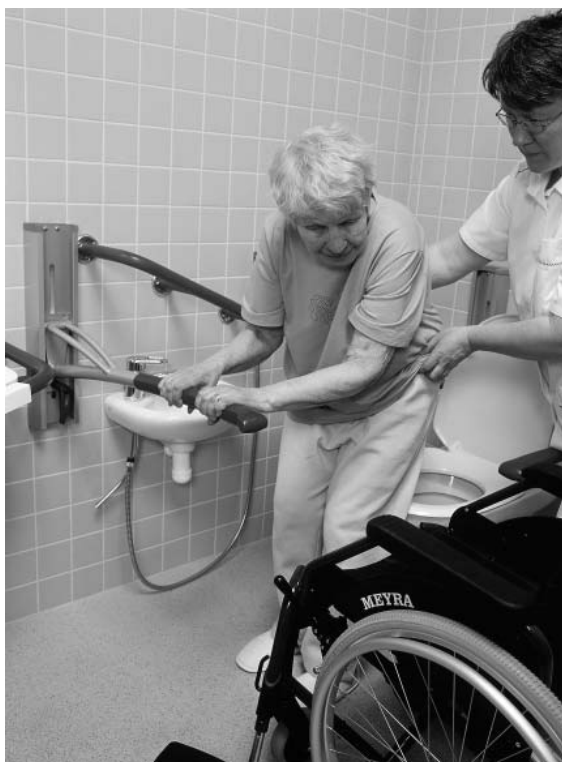
KUVIO 13. Hyvä ratkaisu WC:ssä voi olla seinästä alaslaskettava poikkitanko, johon potilas voi tukeutua.
